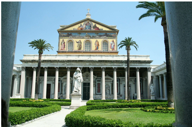
St. Paul vor den Mauern
